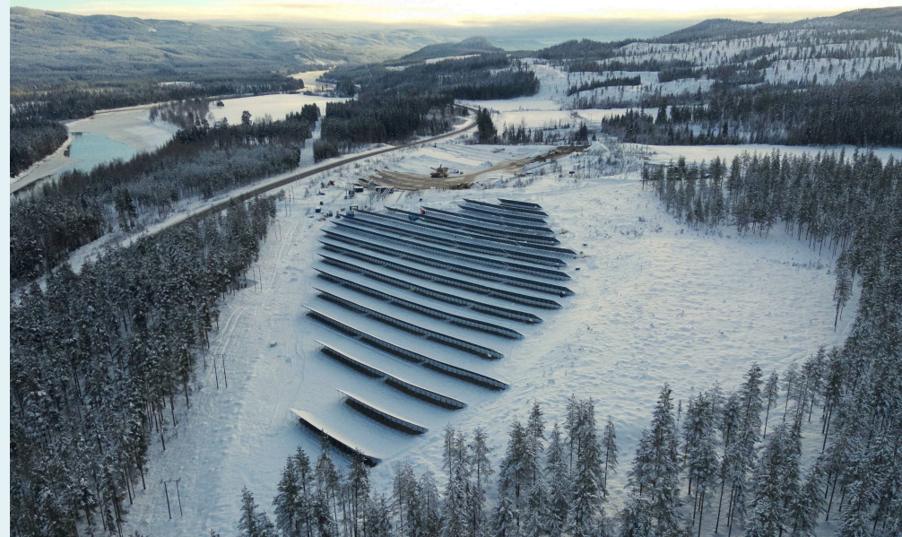
Furusest solkraftverk er under bygging, med første del tilknyttet nettet i november 2023.
