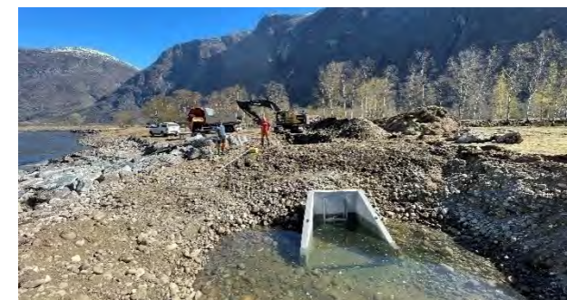
Inntaket på plass i Eriskilen våren 2022
