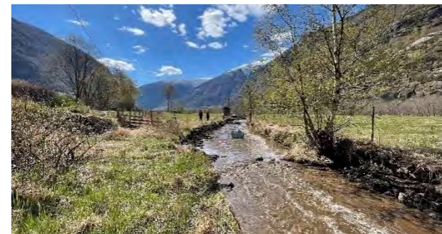
Første vanndråpene på lang tid i Haugekilen. Satt i drift i 2021.
